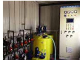
该中试针对市政污水地表准四类水排放标准展开,在原有BioHopp生化反应器内增加后置反硝化区及强曝气区,强化了脱氮除磷功能。对碳源分配、回流比、外部碳源投加量、溶解氧、氧化还原电位等运行参数进行了考察和优化。
